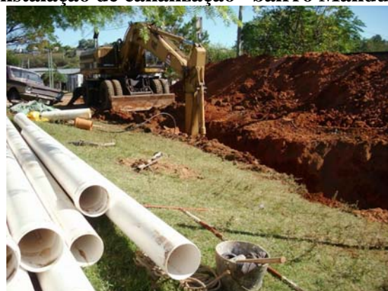
Instalação de canalização – bairro La Pedrera.
